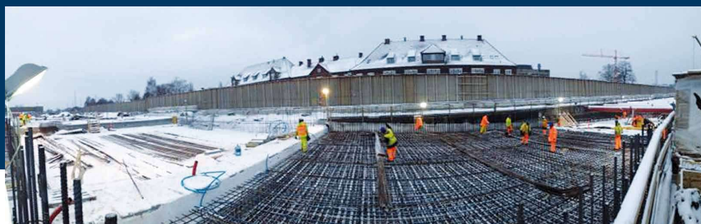
Dalle de base pour les rampes de départ des tunnelier Base slab for the TBM starting ramps
