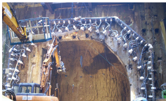
Realizzazione stazione Toledo della Metropolitana di Napoli (Scelta B).
