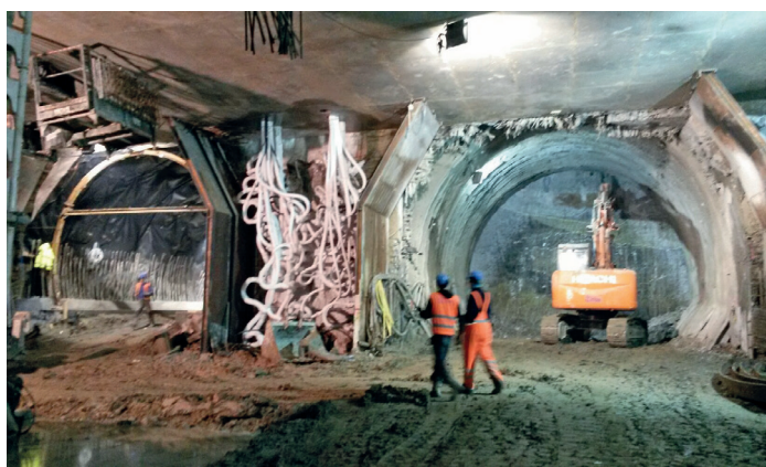
Metropolitana Varsavia – Collegamento stazione C13.
