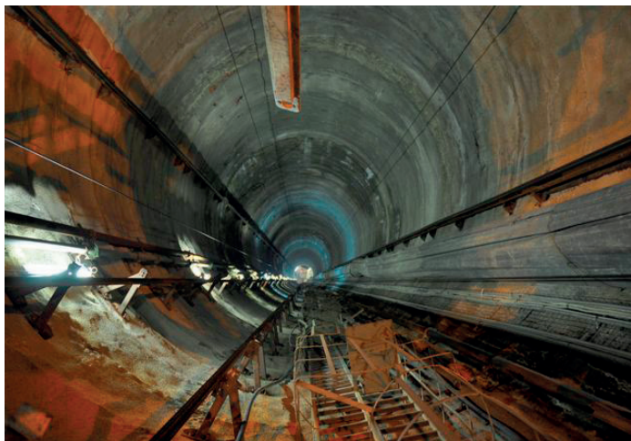
Realizzazione pozzo a quota -300 m. - Elettrodottosorgente Rizziconi - Terna (Scilla Rc).
