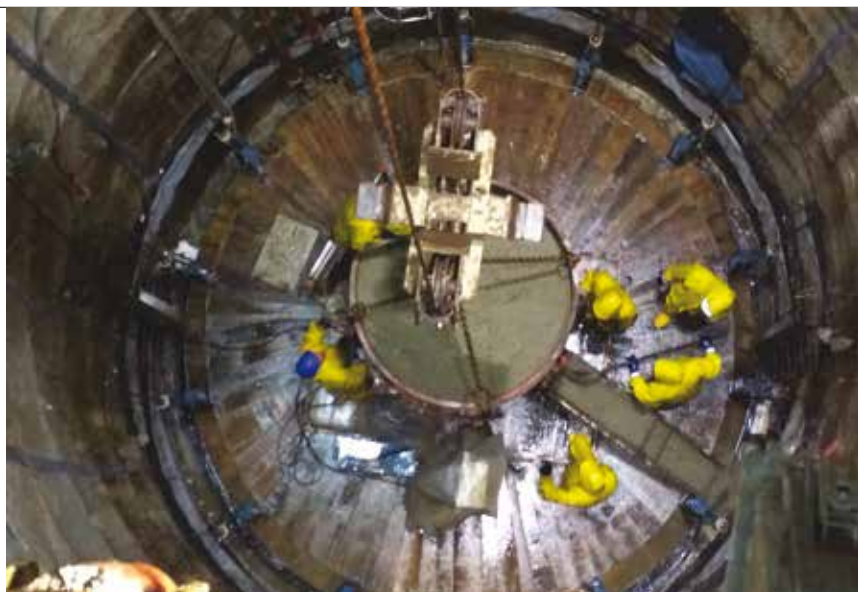
9. La fase di getto del rivestimento definitivo
