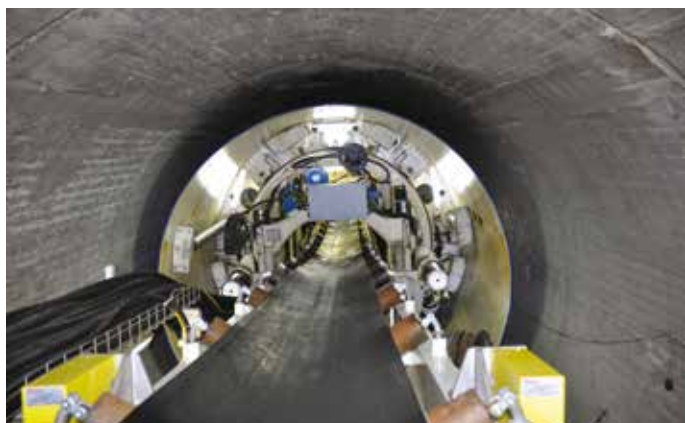
3. Il nastro per lo smarino del materiale
