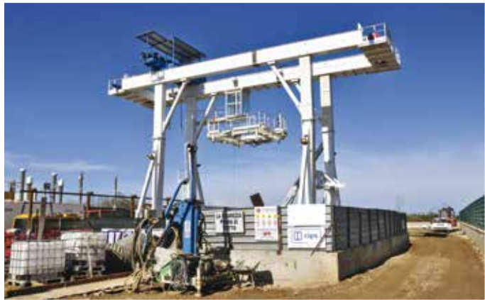
6. Il carroponete a supporto delle varie fasi lavorative nel pozzo verticale di Melia
