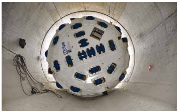
2. La fase di traslazione al fronte della TBM
