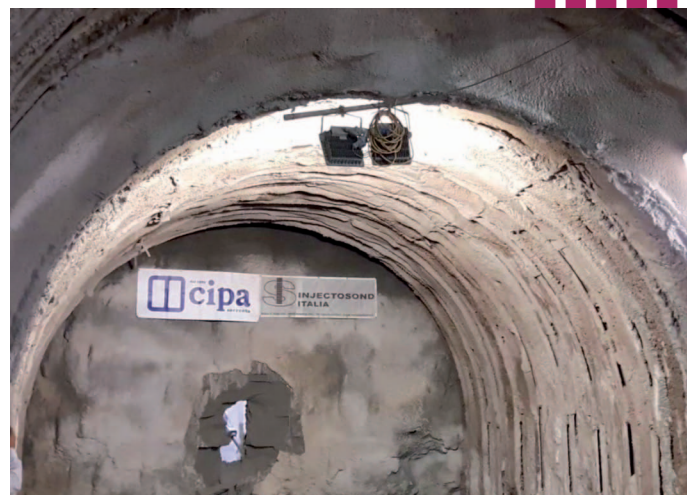
Foratura della galleria con collegamento al pozzo verticale
