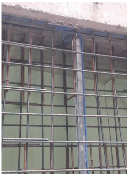
Predisposizione giunti waterjoint, valve injection e break joint del Sistema Penetron Admix nel concio di sottomurazione
