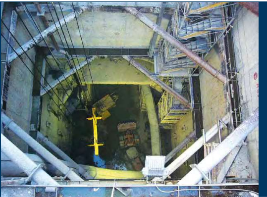
Puits d'accès à la station Corvetto Entrance shaft to Corvetto station
