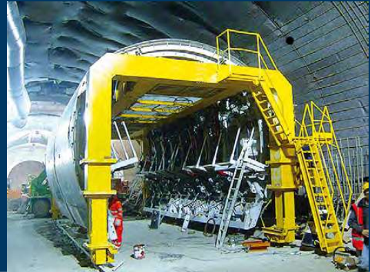
Coffrage pour revêtement du tunnel de la ligne Formwork for line tunnel lining
