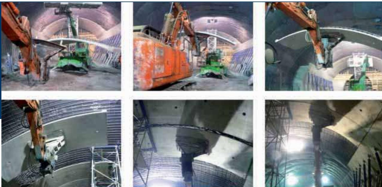
le attività di scavo per il camerone tipo 1, in primo luogo perché la curvatura del tracciato ha portato la galleria al di sotto degli edifici di via Roma e in secondo luogo perché fin dai primi metri di scavo di questo secondo allargo sono state intercettate le due gallerie esistenti Le Grazie, determinando durante l'avanzamento un impatto ambientale di tipo acustico e vibrazionale che ci ha costretto ad interdire lo scavo durante l'orario notturno.
