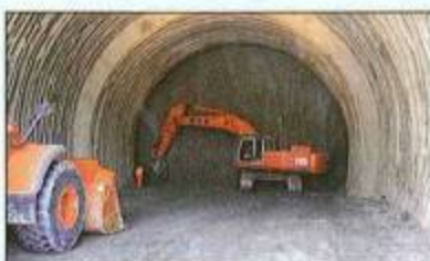
Figura 5 - Lo scavo di avanzamento al fronte
