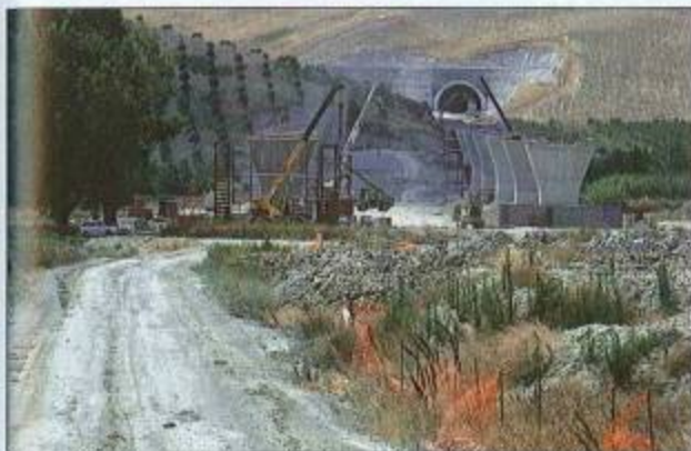
Figura 3 - Il viadotto Varrea e l'imbocco Nord della galleria Girella
