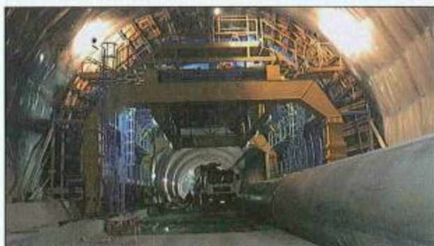
Figura 7 - Il getto del rivestimento definitivo
