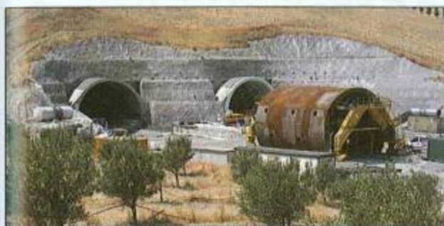
Figura 6 - Il cassero all'imbocco della galleria Girella
