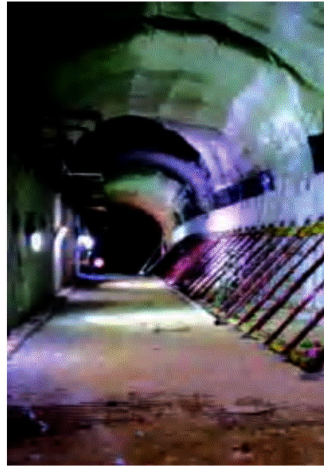
Casseratura e getto calotta galleria di accesso
