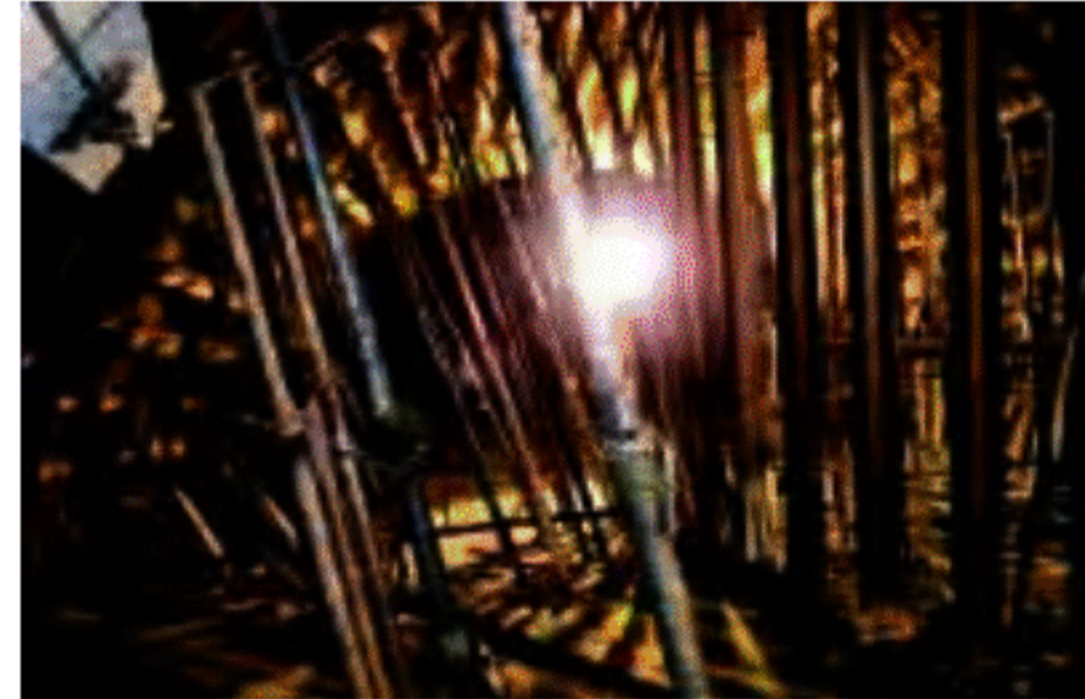
Casseratura e getto calotta galleria di accesso
