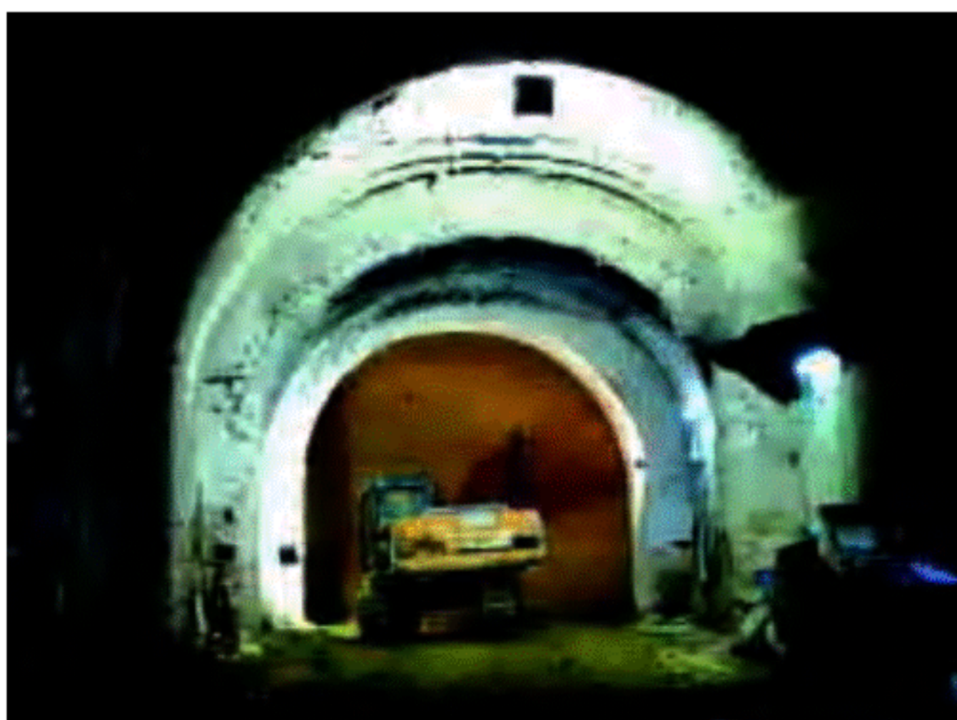
Infilaggi in calotta
