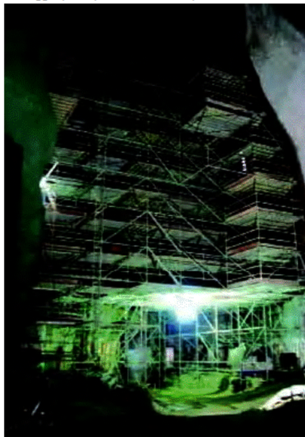
Ponteggio per la posa delle centine per la cavità secondari
