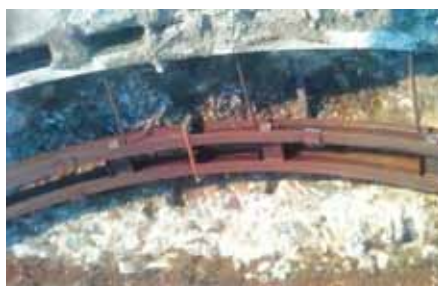
Figura 8 - Centina di calotta
