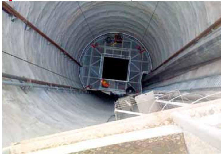
Figura 11 - Installazione di cantiere Melia - piattaforma di servizio
