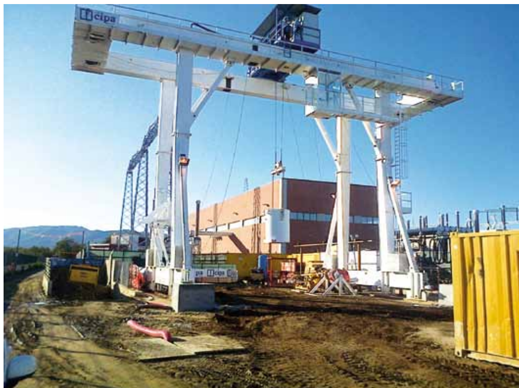
Figura 10 - Installazione di cantiere Melia - Carroponte
