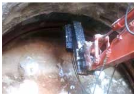
Figura 7 - Posa centina prerivestimento
