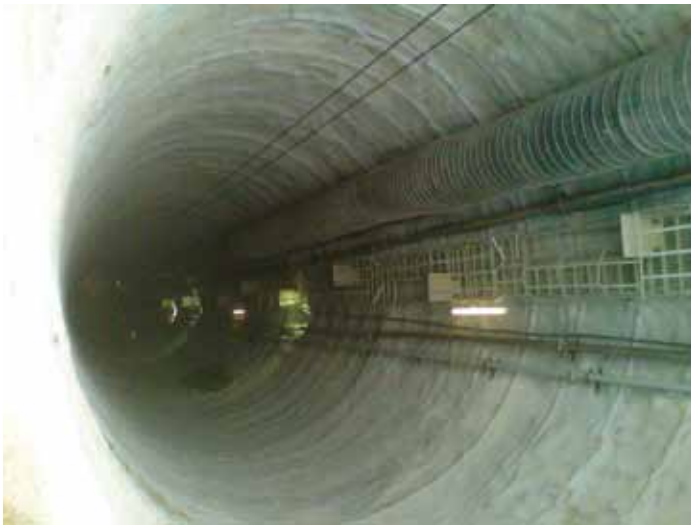
Figura 13 - Sezione tipo SP1 in fase di realizzazione profondità inferiore ai 60 m
