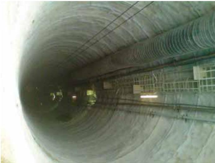
**Figura 13** - Sezione tipo SP1 in fase di realizzazione profondità inferiore ai 60 m
