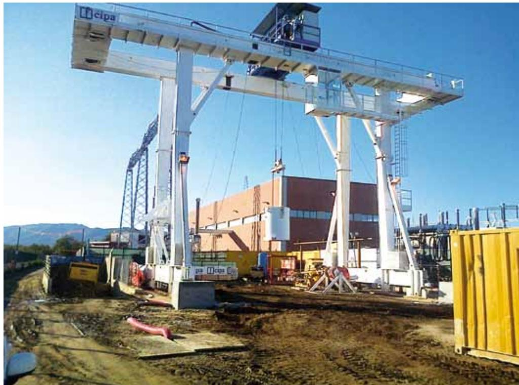
**Figura 10** - Installazione di cantiere Melia - Carroponte
