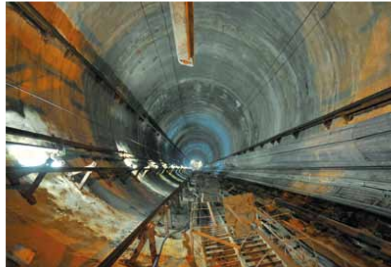
Figura 14 - Sezione tipo SP2 in fase di realizzazione profondità superiore ai 60 m
