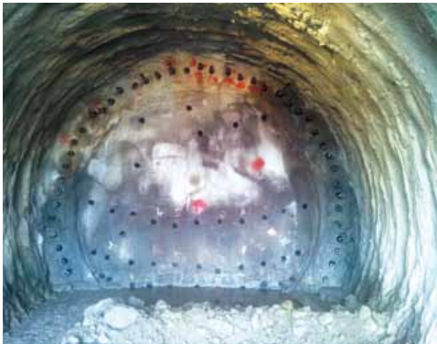
Figura 5 - Consolidamento Sezione SG1
