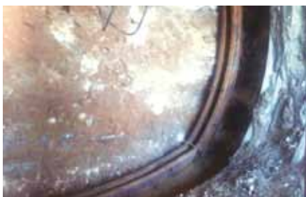
Figura 9 - Centina di arco rovescio
