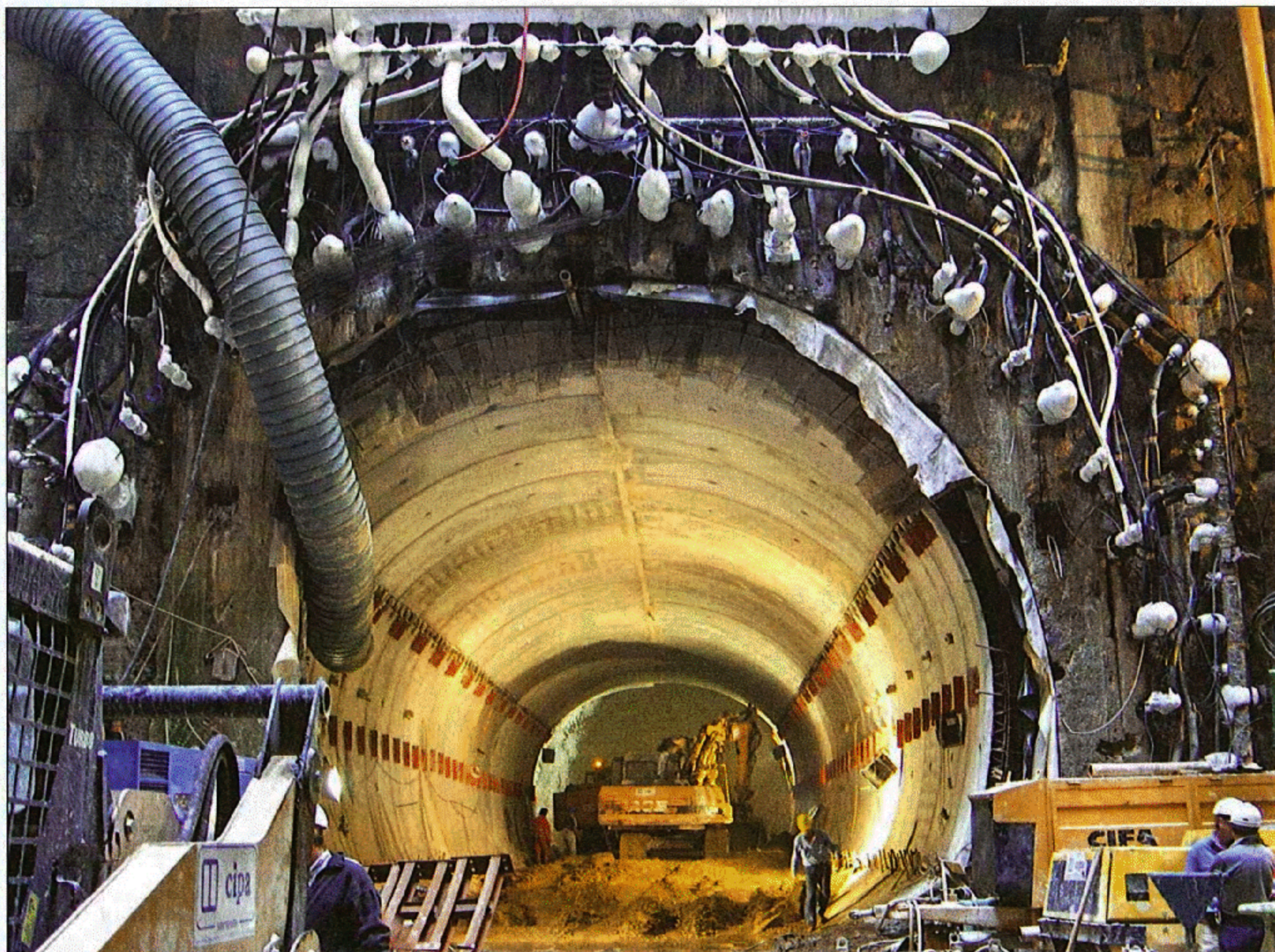
Figura 22 - La galleria di banchina di stazione Garibaldi: lo scavo in tradizionale sotto congelamento
