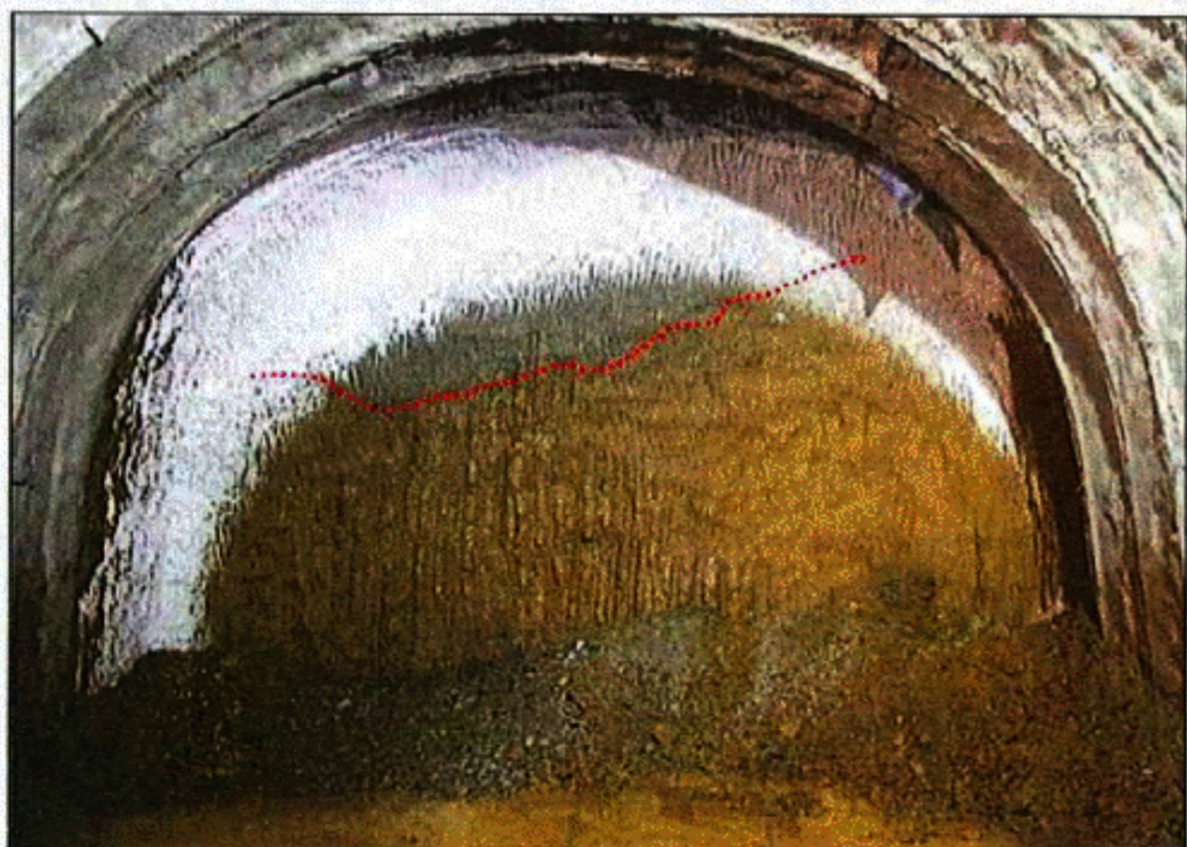
Figura 20 - Lo scavo delle gallerie di banchina sotto congelamento
