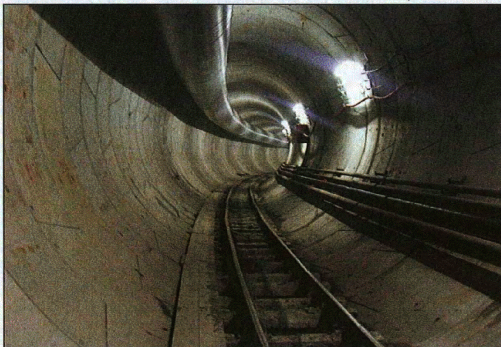
Figura 7 - La galleria di linea realizzata con scavo meccanizzato
