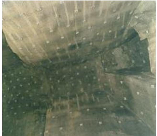
Il CT-Bolt è corredato da un corpo emisferico che manifesta due funzioni: sopporta e distribuisce il carico sulla piastra di ancoraggio e serve da camera di iniezione. Il materiale di iniezione viene pompato nel bulbo di miscelazione ed attraversa la guaina di polietilene, all'estremità superiore lo stesso rifluisce tra la guaina e la roccia fino a sfidare dalla piastra di ancoraggio.
