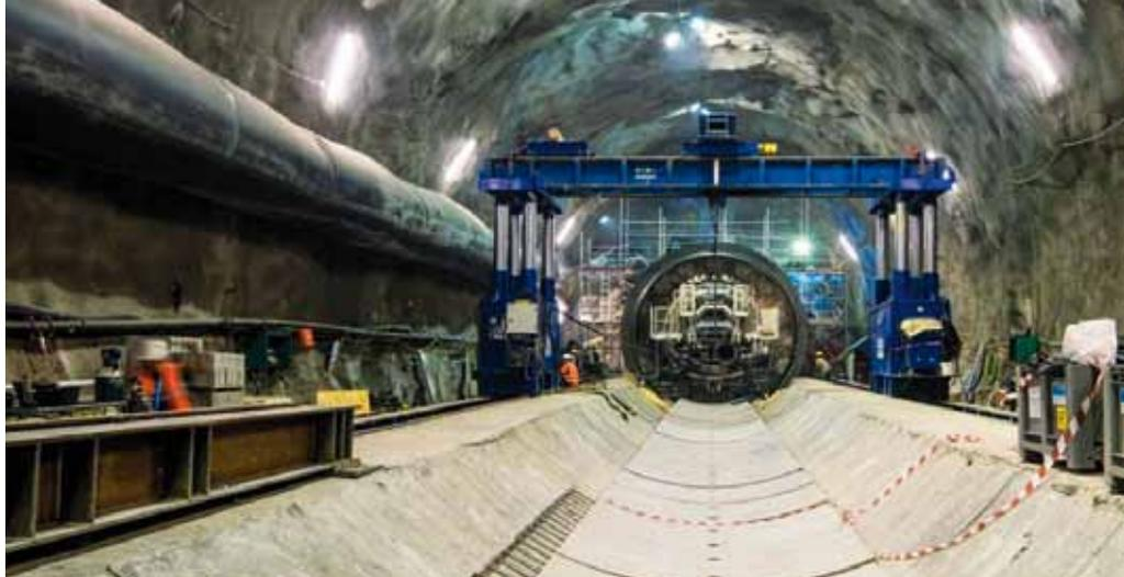
geometriche e la variabilità geomeccanica riscontrabile lungo il tracciato, ma anche per ottimizzare il cronoprogramma, il progetto esecutivo ha previsto tratte scavate con metodo tradizionale ed altre con metodo meccanizzato. In particolare, lo scavo tradizionale è previsto per affrontare le gallerie a doppio binario, la fermata di emergenza con annessa galleria di accesso e tutti i cunicoli trasversali, nonché le gallerie di linea a singolo binario e il cunicolo esplorativo tra la Finestra di
