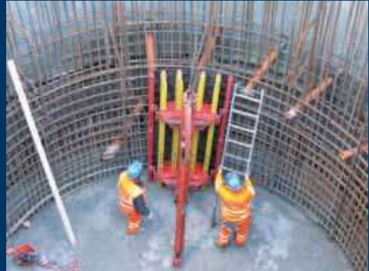
Rivestimento pozzi strutturali Variante di Valico Lining of structural shafts, Variante di Valico
