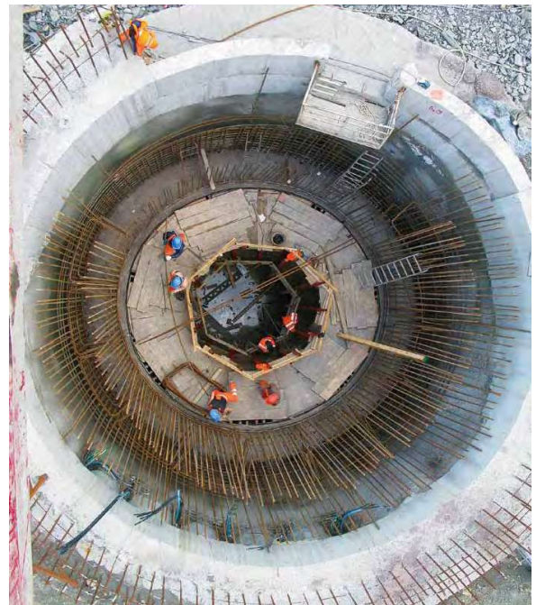
Travaux à l'intérieur d'un puits Working operations inside a shaft
