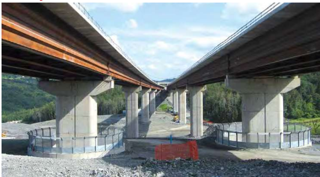
Viaduc Casaglia Casaglia viaduct
