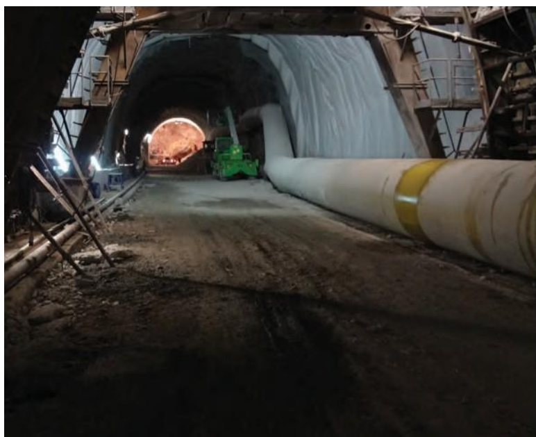
La sperimentazione di Sis.Ca. nella galleria della Sorrentina 2011-2012
