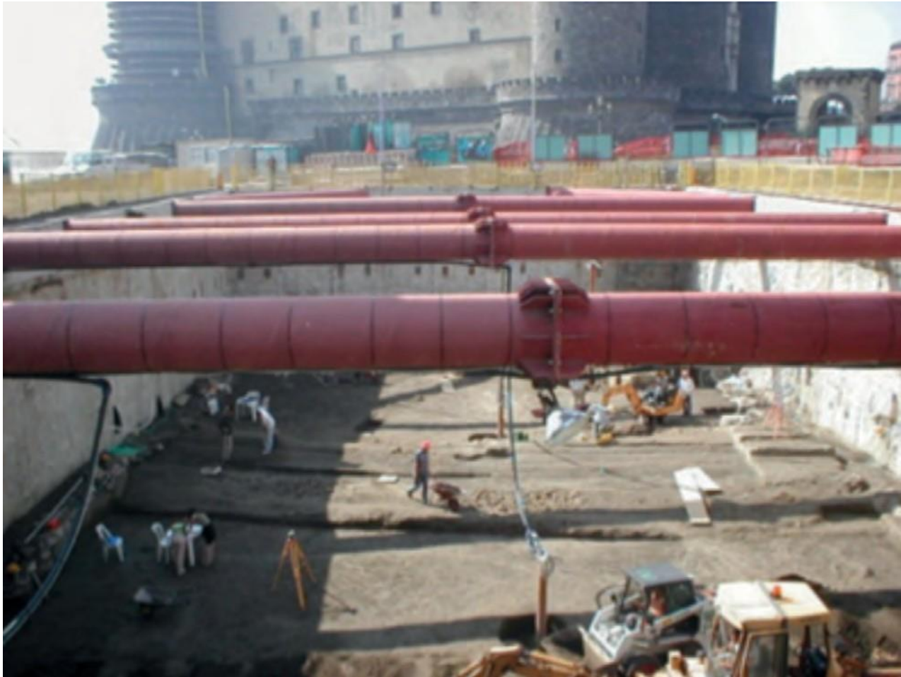
Sperimentazione Si.S.Ca. nel cantiere di Piazza Municipio- Metropolitana di Napoli dal 27/09/12 al 19/10/12- SUDMETRO S.c.a.r.l.
