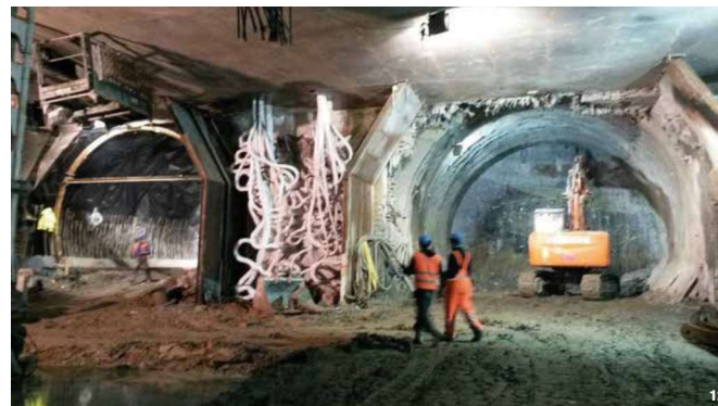
12. Galleria di collegamento della metropolitana di Varsavia eseguita sempre con la tecnica del congelamento
