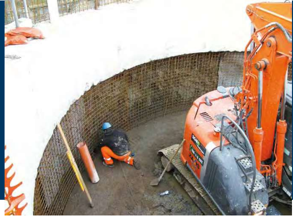
Pose de l'armature pour le voussoir du puits Installation of reinforcement for the shaft segment
