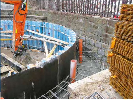
Pose de coffrage circulaire du puits Installing the shaft's circular formwork
