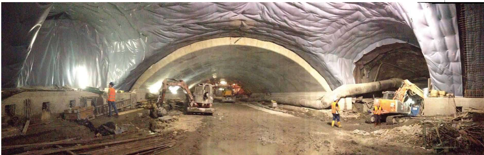
Vue d'ensemble du Tunnel d'entrée Overall view of Entrance Tunnel
